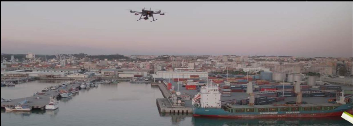
No Porto de Leixões, drones conectados por 5G apoiam na inspeção de estruturas, monitorização e vigilância
